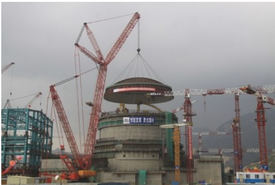
Installation du dôme de Taishan 1 (23-X-2011 Image: CNECC)
